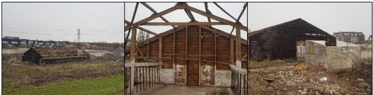
Afbeelding 3: Schuur met op kopgevels na nog alleen het geraamte van het gebouw (links), Kopgevels met in de stal rekken (midden) en kleine schuur met bakstenen muren (rechts).
