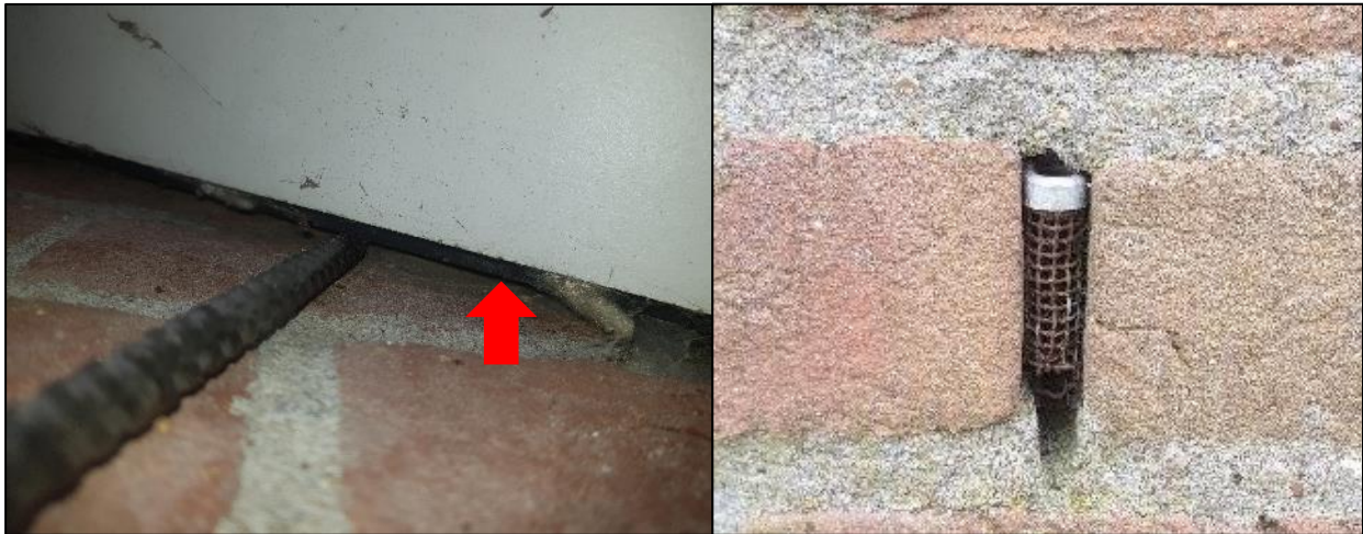
Afbeelding 2: Ruimte tussen daklijst en gevels afgesloten met lat (rode pijl) en afgesloten stootvoegen (rechts).
